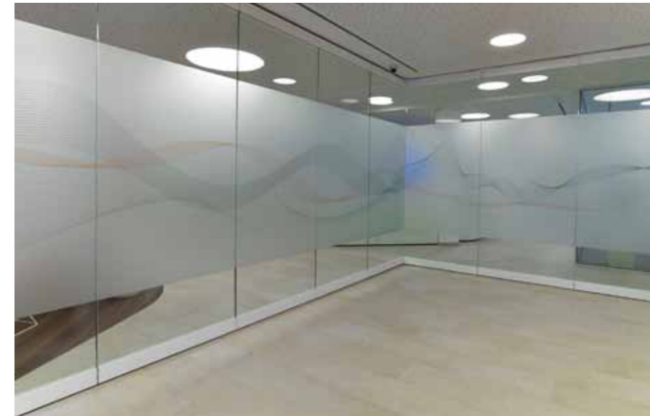
Mobile Automatikwand im geschlossenen Zustand zur Tag- / Nachtabtrennung
